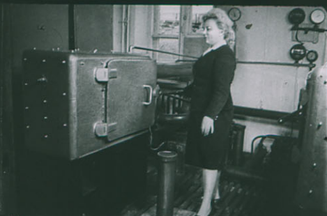
Пневмопочта для пересылки грузовых документов из товарной конторы в техническую и на грузовой двор (типовой проект № 501-67 института „Гипротрансигнальсвязь“). [49]
