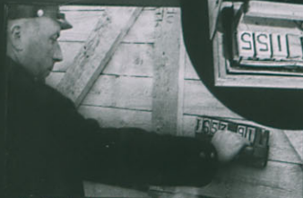
На станции Швенчёнис Прибалтийской железной дороги применяется приспособление для маркировки грузов. На счетчике приспособления указывается количество замаркированных грузовых мест. [48]
