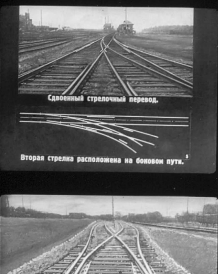
Схема стрелочного перевода с указанием его основных элементов.
