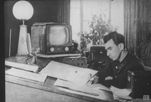
Помещение станционного диспетчера.
