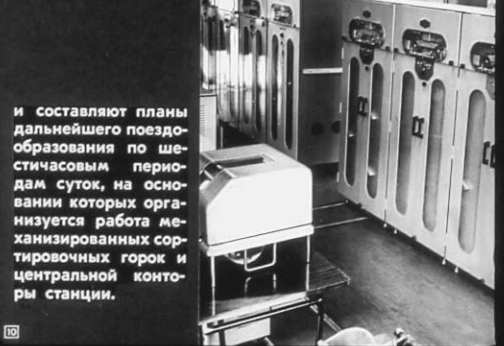
В этих центрах информацию о подходе и назначении вагонов и грузов, поступившую со станций отправления грузовых поездов соседних отделений, обрабатывают на электронно-вычислительных машинах
