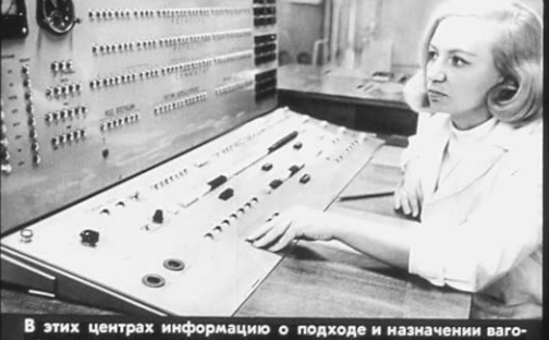
В этих центрах информацию о подходе и назначении вагонов и грузов, поступившую со станций отправления грузовых поездов соседних отделений, обрабатывают на электронно-вычислительных машинах
