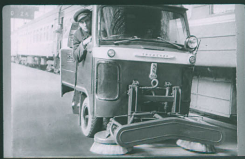
Для механизированной уборки платформ, перронов и привокзальных площадей используется тротуароуборочная машина ТУМ-975, которая летом подметает, не поднимая пыли,
