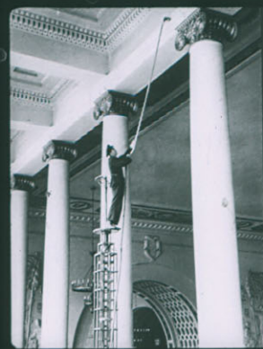
Телескопическая вышка используется при обметании стен, потолков, чистке люстр и других работах на большой высоте.
