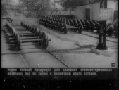
Цехи цеховой подготовки для хранения сортированных колёсных пар по типам и диаметрам круга колёса.
